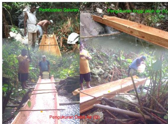
Gambar 1. Pembuatan Saluran, Pengukuran Debit (Q) & Tinggi Air Jatuh (h)
